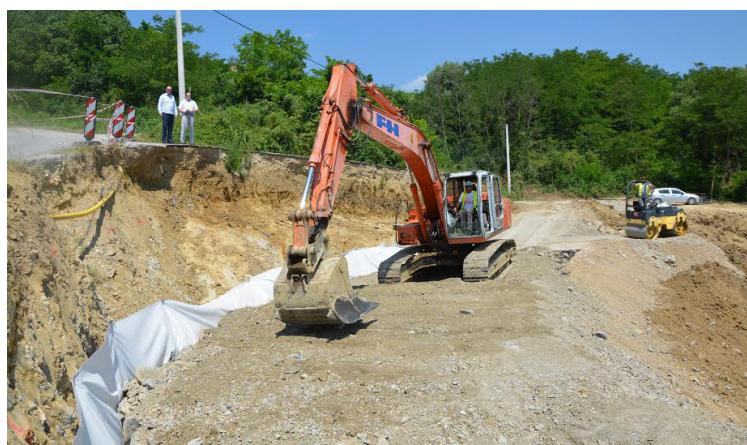
Izvođač radova na saniranju klizišta je Milengrad Budinčina. Klizište neće biti sanirano na klasičan način, gradnjom potpornog zida, već specijalnom tehnikom stepeničastih kaskada koje se ispunjavaju zamjenskim materijalom i ojačavaju geo mrežama,
