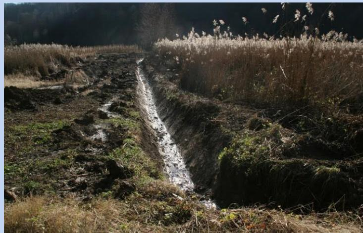
Na području Gornje Stubice, u Pasanskoj Gorici, iskopani su odvodni kanali koji se nalaze neposredno u blizini potoka Burnjak. Očišćen je teren, obavljena je sječa granja i raslinja, iskopani su odvodni kanali, izgrađen je propust kroz koji oborinska voda sada prolazi u potok Burnjak te su napravljeni prilazi mještanima na njihove poljoprivredne parcele. Tim je radovima oborinska voda regulirana te sada protjeće kroz odvodne kanale u potok i više se ne zadržava na općinskom putu
