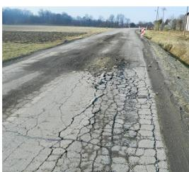
Mještani ogorčeni: To ti je tak, kad podloga ni napravljena onak' kak' Bog zapoveda, onda ni cesta nemre zdržati
