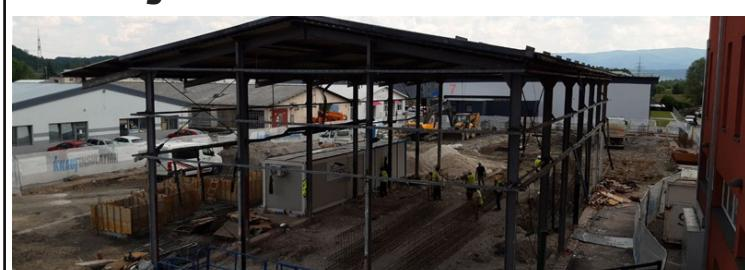
Intenzivirali su se radovi na rekonstrukciji društveno-kulturnog centra re-GENERATOR u Zaboku. Srušene su postojeće tri hale te dijelom hala re-GENERATORA, preostala je još jedino čelična nosiva konstrukcija. Izveden je privremeni priključak vode, a trenutno se
